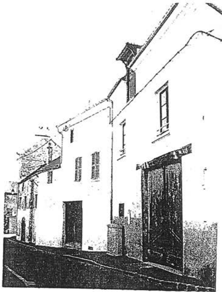
vue sur les pignons, hauteurs variables...
