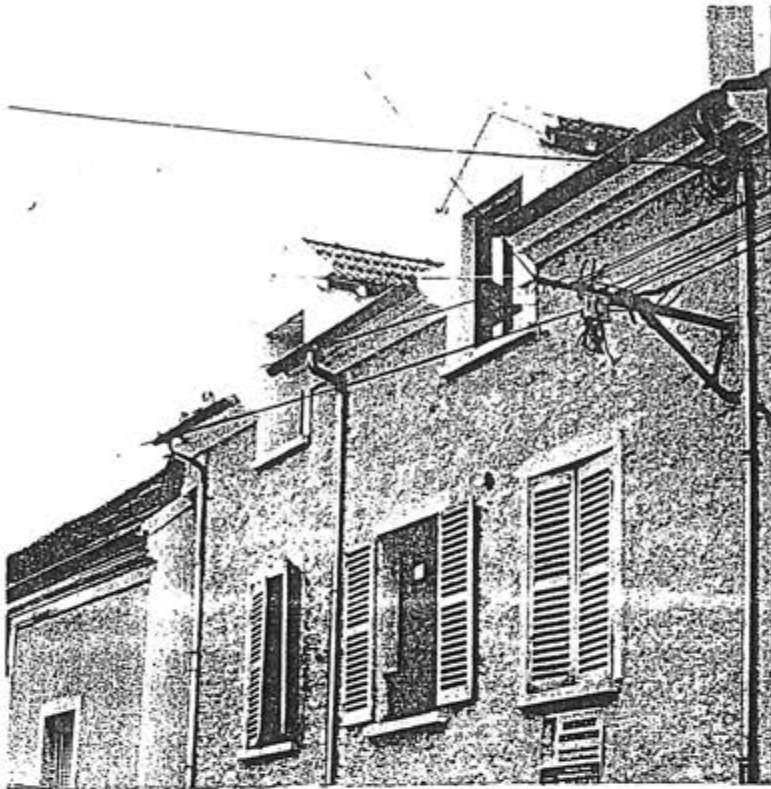
Façade en maçonnerie de moellon enduite à "pierre-vue"
