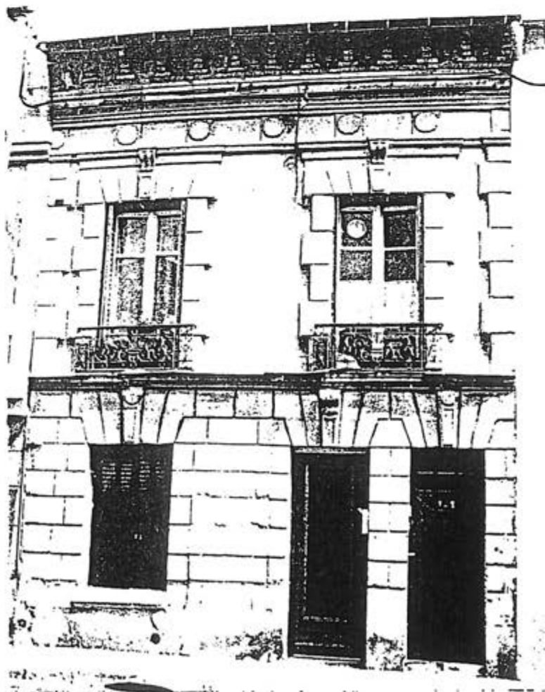
Façade en maçonnerie de pierres appareillées
