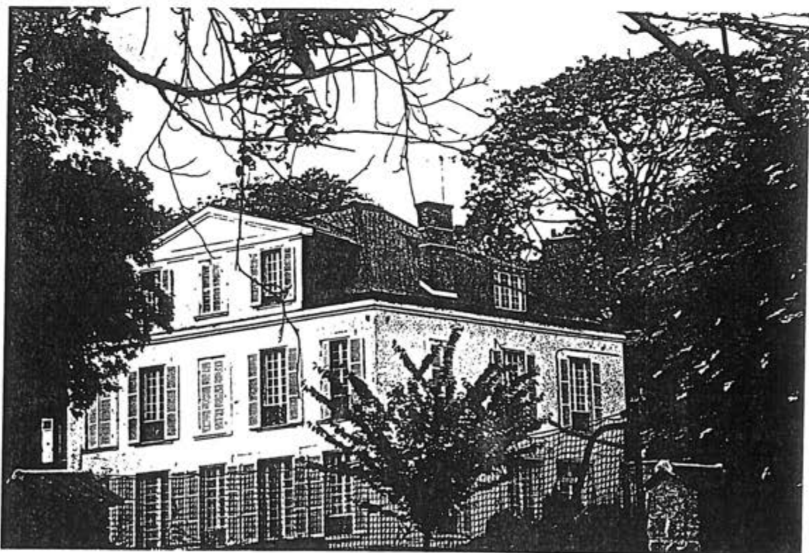
Façade en maçonnerie enduite
